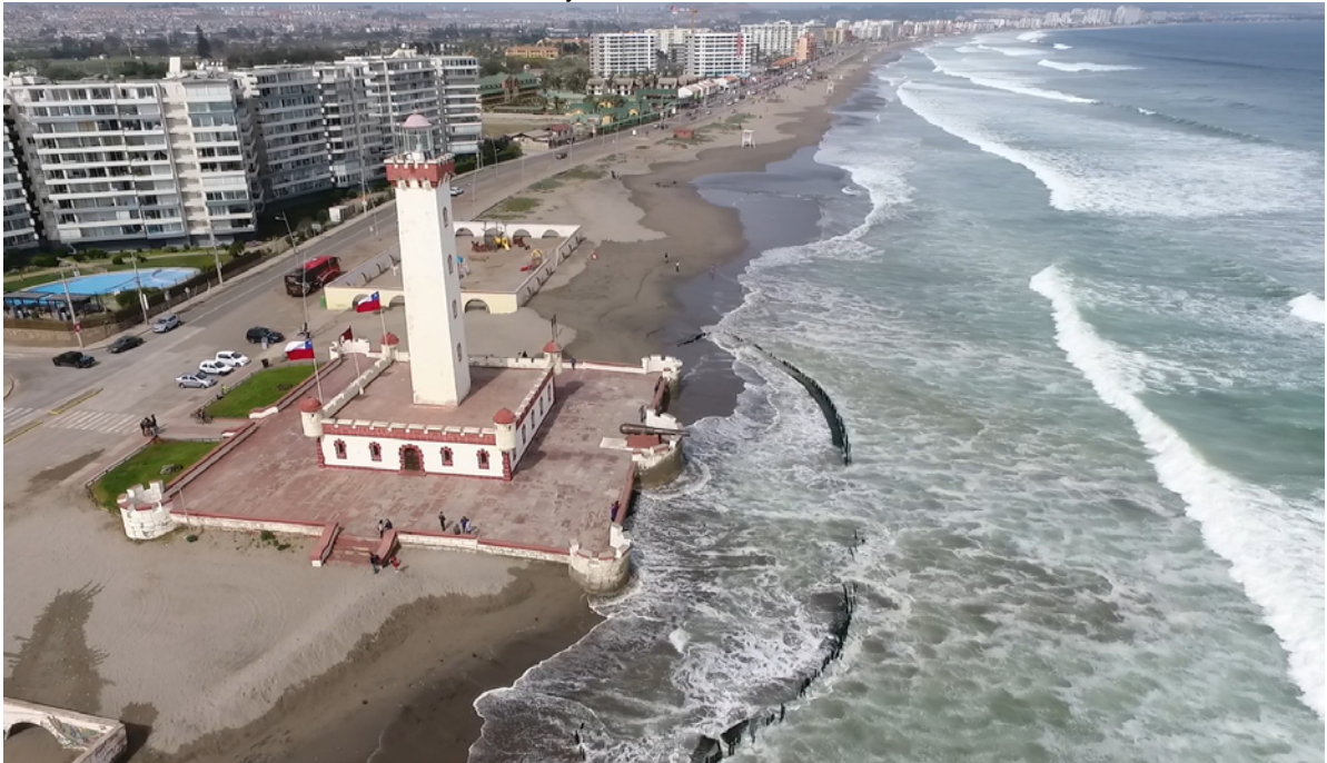
Figura N°15. Faro de La Serena, en la Bahía de Coquimbo, que ha experimentado erosión costera producto de la construcción del Embalse Puclaro y de la extracción de áridos
