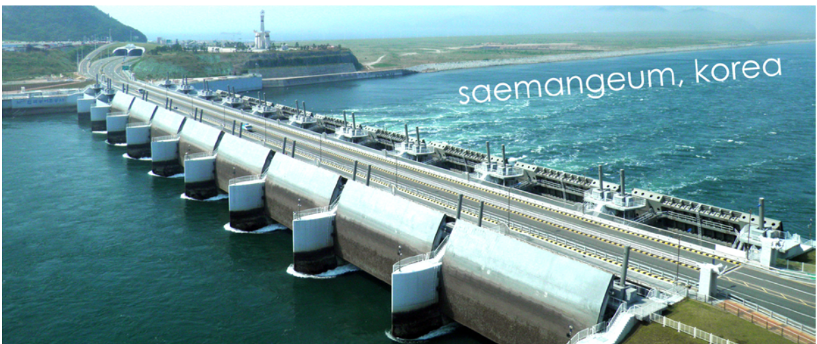
Figura N°6. Central mareomotriz en el estuario de Saemangeum, Korea, durante una visita en 2014. La planta contempla un rompeolas de 33 kilómetros –el más grande construido a la fecha- que divide el estuario del Mar Amarillo. El estuario, que eventualmente se colmatará en el futuro, de destinará a terrenos agrícolas e industriales
