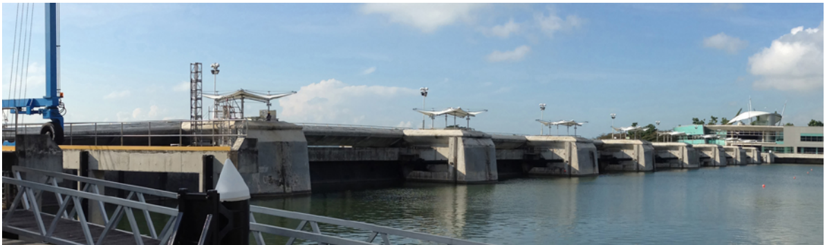
Figura N°4. Marina Barrage, Singapur, en una visita en 2016
