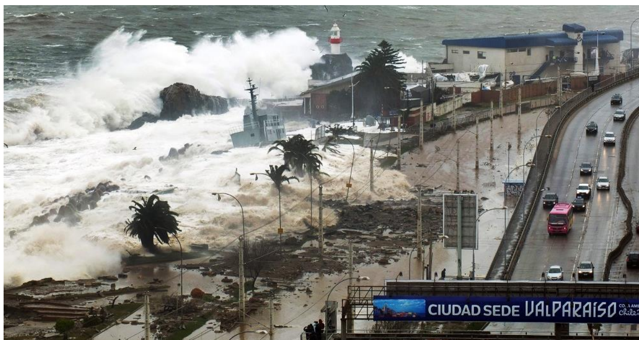
Figura 19: Arriba: Sobrepaso en Av. España, Valparaíso, debido al temporal del 8 de agosto de 2015 (Winckler et al., 2017). Producto de las olas, se destruyó la defensa y se cortó la línea del metro entre Valparaíso y Limache. El flujo llegó incluso a la avenida, lo que se evidencia en el desplazamiento de las barreras tipo New Jersey en la esquina inferior derecha de la foto.
