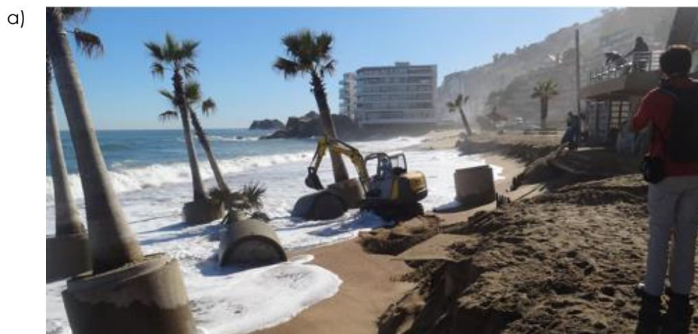
Figura 4: Playas urbanas de Valparaíso y Viña del Mar afectadas por las marejadas del 26 de junio de 2017. a) Playa Reñaca, donde las olas socavaron cimientos de locales comerciales. b) Playa Las Salinas, siendo tercera vez que las marejadas causan graves daños en balneario. c) Playa Portales, donde se generó un escarpe de 2,5 [m] en la playa y locales comerciales fueron dañados por el impacto de las olas.
