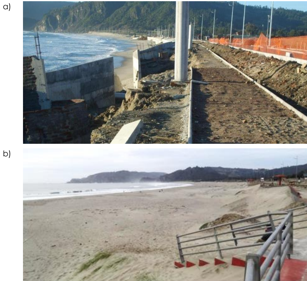
Figura 3: a) Costanera construida sobre antedunas en playa de Lebu, Región del Biobío, y destruida por un frente de mal tiempo (no extremo), con un costo millonario. La fotografía fue tomada el 5 junio 2008. b) Playa de Lebu ensanchada debido al alzamiento costero de 1,8 [m] provocado por el terremoto del 27 de febrero de 2010. La fotografía fue tomada en julio 2012.
