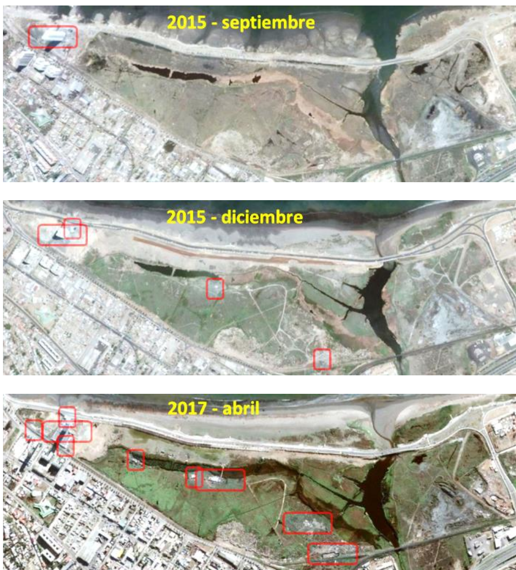
Figura 5 (cont): Evolución de las intervenciones antrópicas en el humedal El Culebrón. Las edificaciones al interior del álveo son señaladas con los recuadros rojos. Fuente: Zuleta & Contreras-López (2019).
