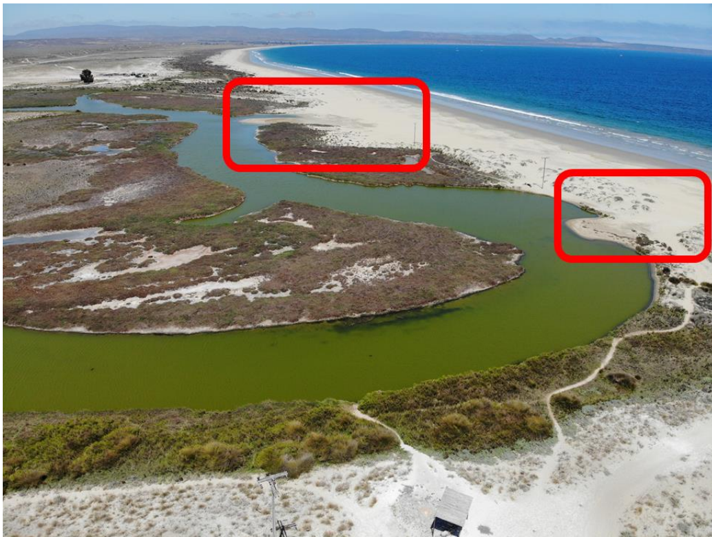
Figura 4: Arriba: Vista área del humedal Salinas Chica en la Bahía de Tongoy. Se resaltan los lugares donde la falta de duna explica los sobrepasos por marejadas que experimenta este humedal. Abajo: Se destaca la acumulación de residuos sólidos y marcas de erosión por oleaje en la ribera oriental de la laguna. La ribera occidental en la barra de arena presenta también claros signos de erosión y sobrepaso por oleaje. Fotografías tomadas en agosto 2017. Fuente: Zuleta & Contreras-López (2019).
